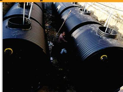
حزمة معالجة مياه الصرف الصحي هي في الواقع مصفاة كاملة و بحجم صغير، وبجميع وحدات المعالجة لديها لكن في أصغر حجمها. يمكن استخدام هذه الحزمات لمعالجة مياه الصرف الصناعي أو الصحي. نظرًا للعديد من الفوائد، اليوم يتم استخدام هذه الحزمة على نطاق واسع وعلى المستوى العالمي. يتم إنتاج حزمة معالجة مياه الصرف الصحي لشركة ابرام الهندسية بساعات مختلفة، مصنوعة من المعدن والبولي إيثيلين والألياف الزجاجية. يتم تصميم هذه الحزمة بطريقة يمكن أن تلبي بسهولة معايير إدارة حماية البيئة.
